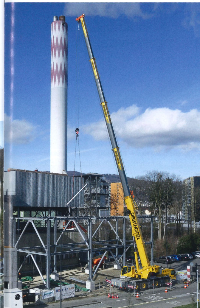
Der LTM 1120-4.1 bei Stahlbauarbeiten an der Müllverbrennungsanlage in Biel
