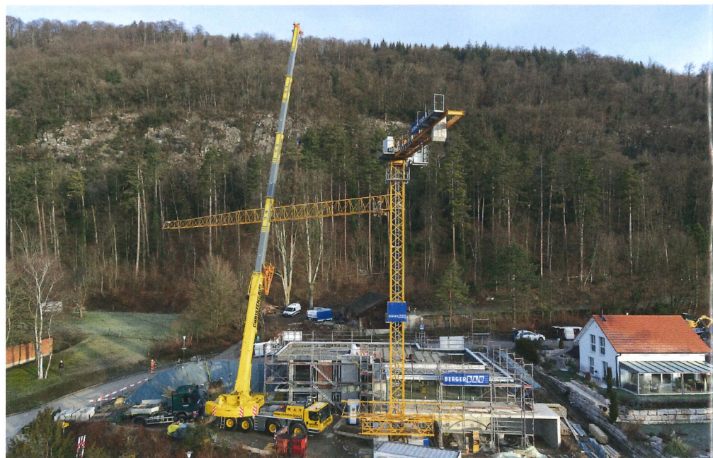
Einhub der 9 t schweren Drehbühne des Liebherr 85 EC-B-Turmdrehkrans.
